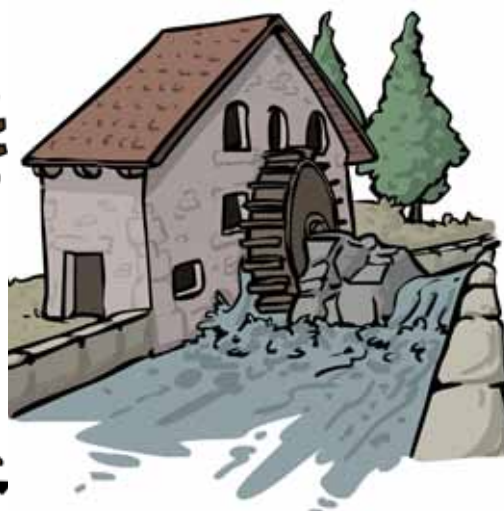
Muíño de rodicio vertical, pouco frecuente en Galicia e propio das forxas hidráulicas
