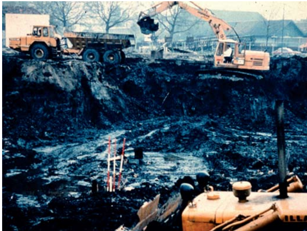
Solos extremamente poluídos na Holanda, para os quais é fundamental a escavação
