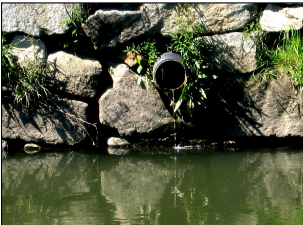
Imaxe dun dos tubos. Fotografía R. Fompedriña Añón
