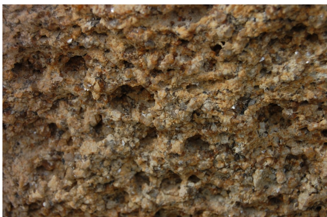
Erosión de la fachada Sur.
