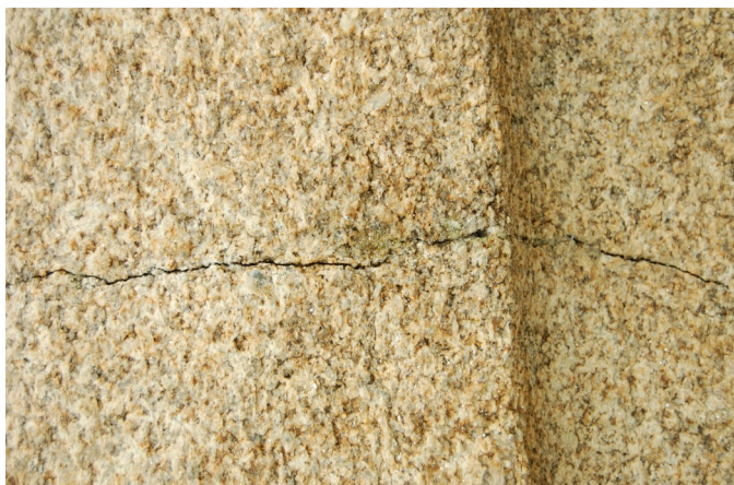
Erosión de la fachada Norte.
