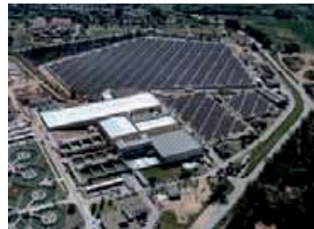
Figura 6 d) Unha planta desalinizadora en Catalunya.
