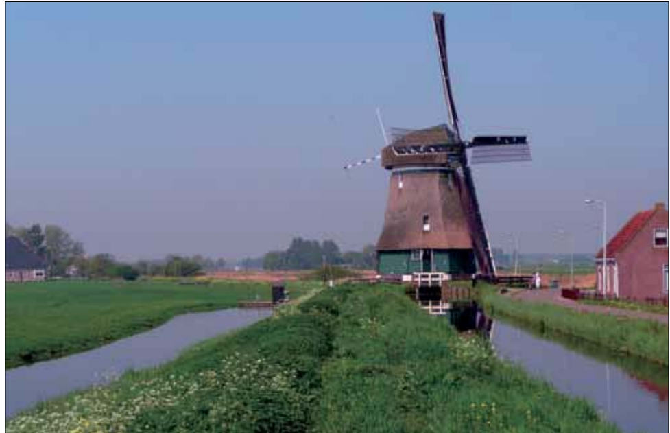
Figura 50. Foto de dous canles conectados polo sistema de bombeo do muíño, o inferior é o da dereita e o superior o da esquerda. O muíño permite o bombeo dende o inferior ao superior.
