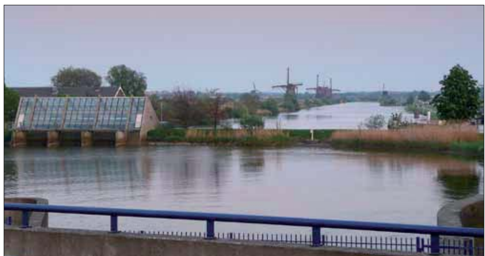
Figura 49. Foto dun punto de bombeo dende un canle inferior no que se ven os muiños, cara o superior que é o que se ve en primeiro plano.
