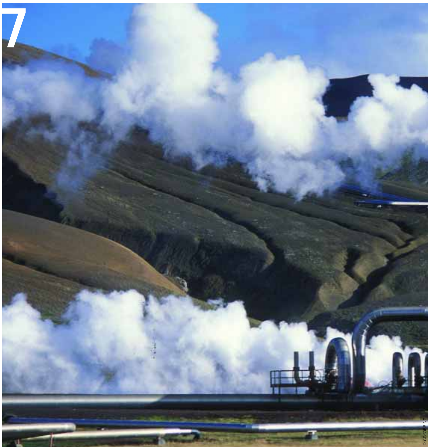
imagen CENTRAL DE PRODUCCIÓN DE ENERGÍA CERCA DE REYKJAVIK, PRODUCE ENERGÍA APROVECHANDO LA ACTIVIDAD GEOTÉRMICA. DESTACAN LAS ROCAS VOLCÁNICAS DETRÁS DE LA CENTRAL. NOROESTE DE ISLANDIA.
