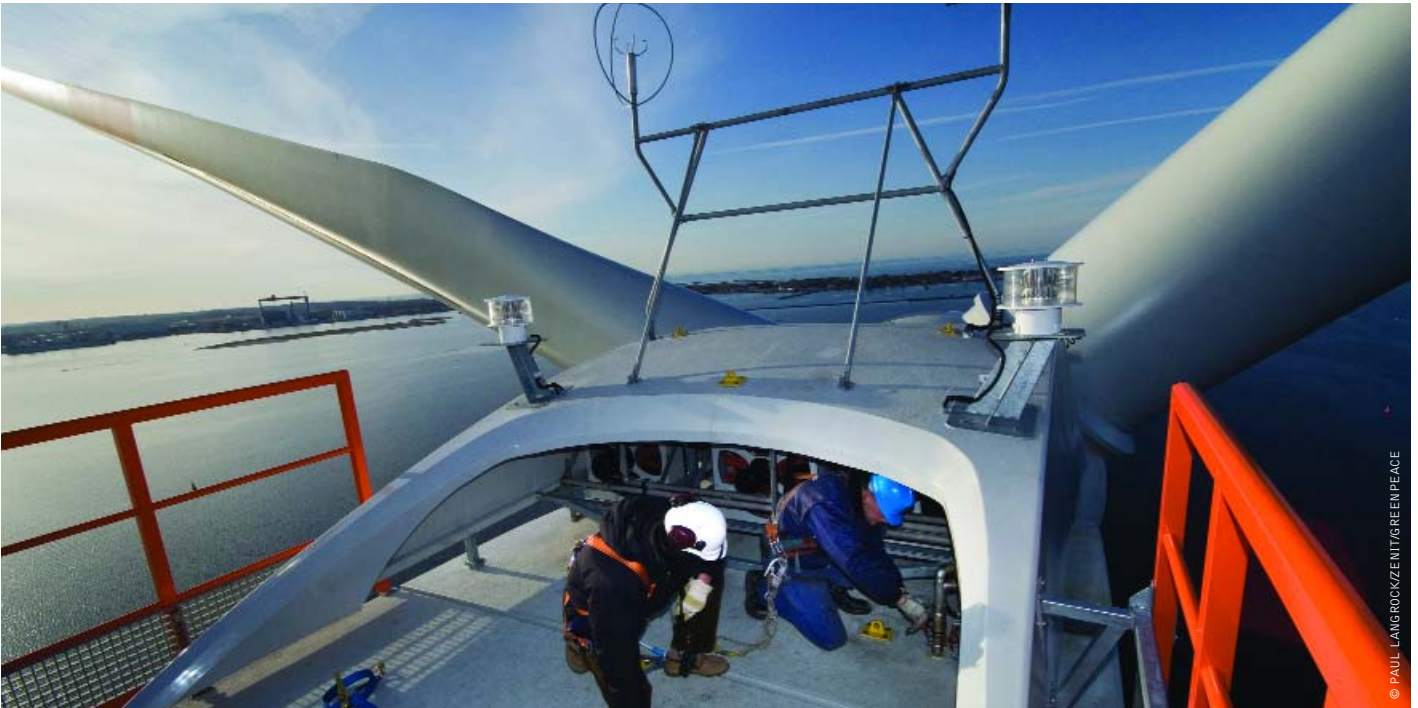
imagen TEST DE UN MOLINO EÓLICO N90 2500, CONSTRUIDO POR LA COMPAÑÍA ALEMANA NORDEX, EN EL PUERTO DE ROSTOK. ESTE MOLINO EÓLICO TIENE 2,5 MW DE POTENCIA Y ES TESTADO EN CONDICIONES OFF-SHORE. PARA 2007 SE EMPLAZARÁN POR LO MENOS 10 INSTALACIONES COMO ÉSTA A 20 KM DE LA COSTA DE LA ISLA DARSS, EN EL MAR BÁLTICO. DOS TÉCNICOS TRABAJANDO EN LA TURBINA.
