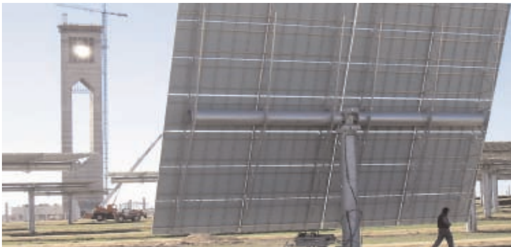
Construcción de la Central PS10 en Sanlúcar la Mayor (Sevilla).
