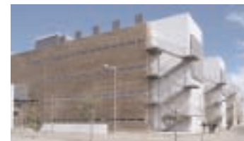
Edificio bioclimático. La minimización de las ventanas en la fachada sur con el uso de persianas laminadas ayuda al mantenimiento de la temperatura de confort según la época del año
