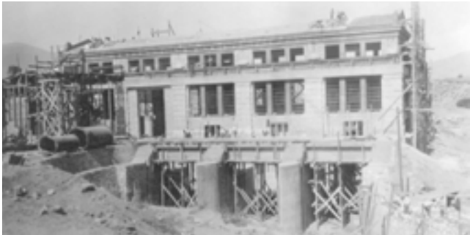
1928. Construcción C.H. Puente Nuevo (Ávila)
